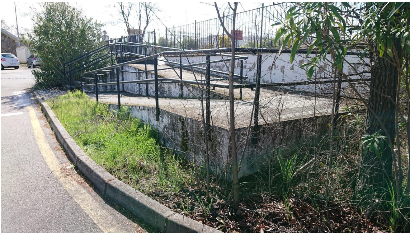
Imagen 21: situación del acceso principal a la Facultad previo a la intervención.
