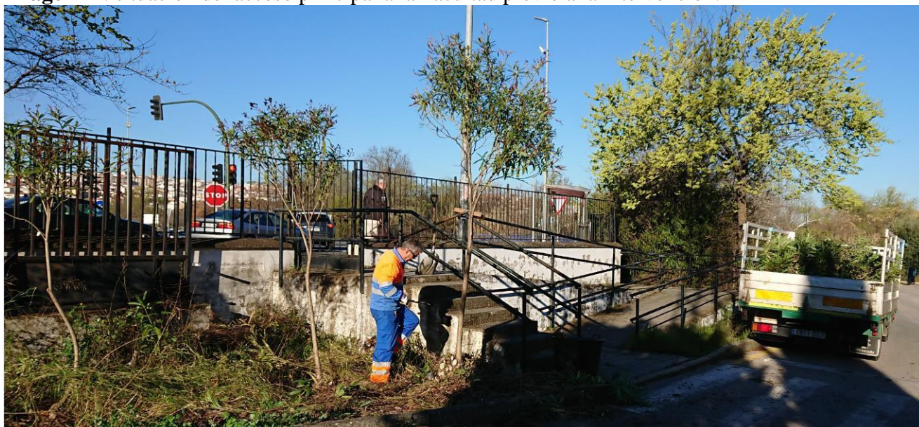
Imagen 22: proceso de la intervención.
